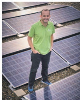
Bild: © Stadtwerke Fürstenfeldbruck: PV-Experte Florian Lehmeier empfiehlt einen Batteriespeicher als sinnvolle Ergänzung einer Photovoltaik-Anlage
